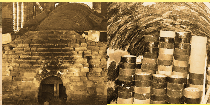
传统的中国龙窑，填充口及用电高频瓷填充的方法 (私人收集)
