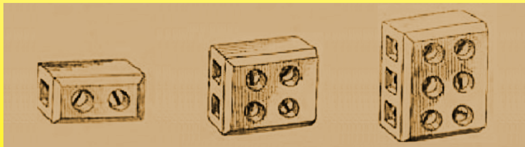
1936年高频瓷接合端子，没有安装孔 (Samet 目录书, Ultimheat 博物馆)
